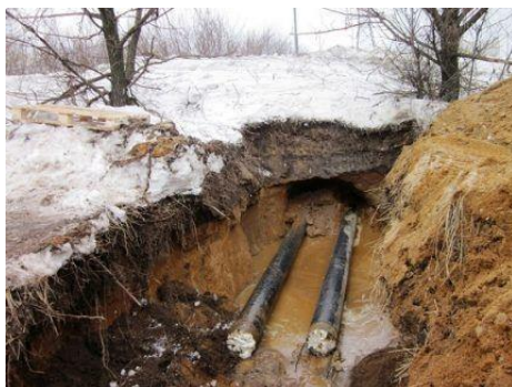
Рис.4. Прокладка труб зимой
