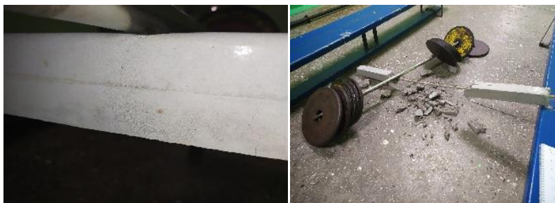
Рис. 17 и 18. Разрушение балки
