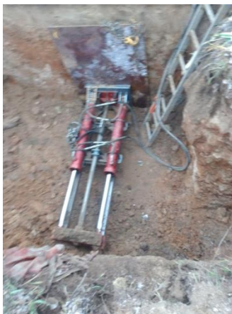
Рис.3. Установка для прокола грунта
